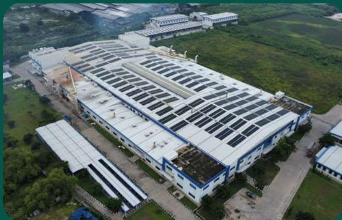
Pemasangan Solar Panel
