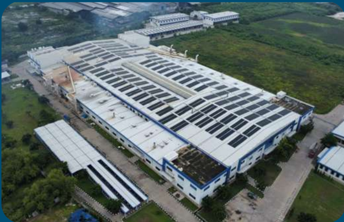
Pemasangan Solar Panel
